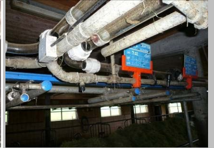
Unsaubere Melkmaschine / Vakuumleitung
